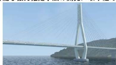
図3 ケーブル系橋梁である斜張橋のCG画像
