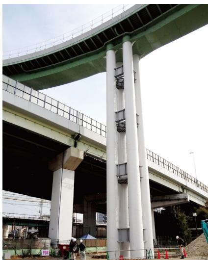
開発した鋼管集成橋脚が採用された海老江JCT
