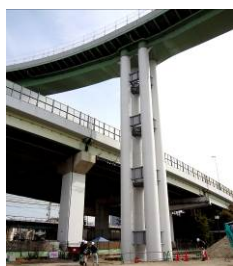
鋼管集成橋脚
