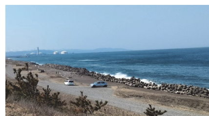
図-4 侵食が進む大潟海岸（上越市）
