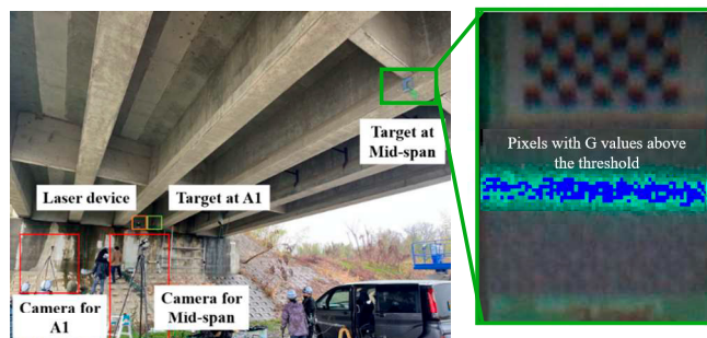
レーザー光と画像計測を用いた変位計測手法の現場実験
