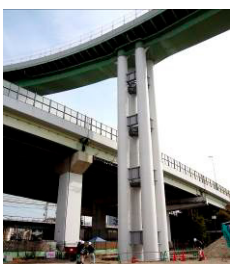
鋼管集成橋脚
