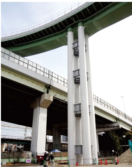
開発した鋼管集成橋脚が採用された海老江JCT
