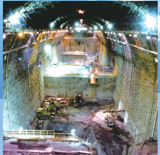
世界最大級の揚水発電所用空洞
