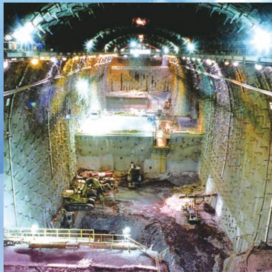
世界最大級の揚水発電所用空洞
